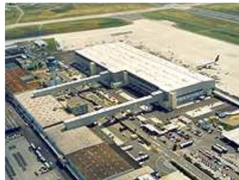
Neues Sortierzentrum von UPS am Flughafen Köln/Bonn.
